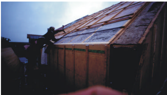
Montage der Vordachschalung
