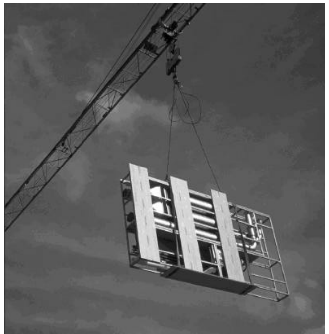
Modulbauelement beim Einbau
