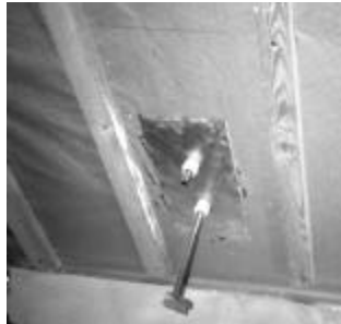
Dachdurchbruch für Solarleitung
