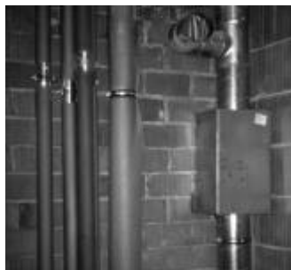
Leitungsführung Schalldämpfer (Foto's: Büro Andreas Lackenbauer, München)
