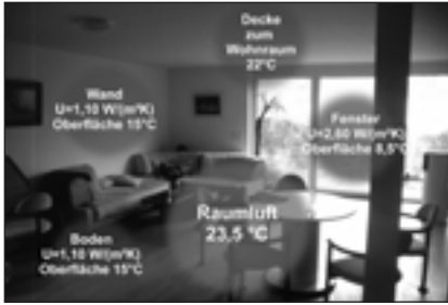
Abb. 2: Schlechte Dämmung: trotz hoher Raumlufttemperatur große Unterschiede in der Wärmeverteilung im Raum, Wohnbehaglichkeit ist gestört
