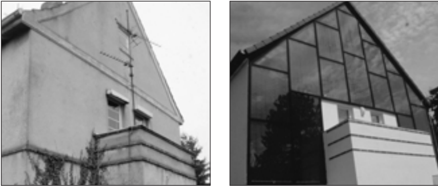
Abb. 93: Südgiebel im Ursprungszustand und mit Solarkollektor (Eigenleistung der Bauleute)
