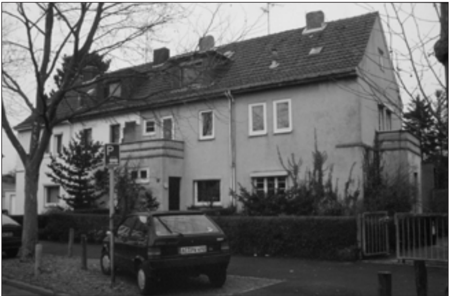
Abb. 83: Reihen-Endhaus (rechtes Gebäude) vor der Sanierung
